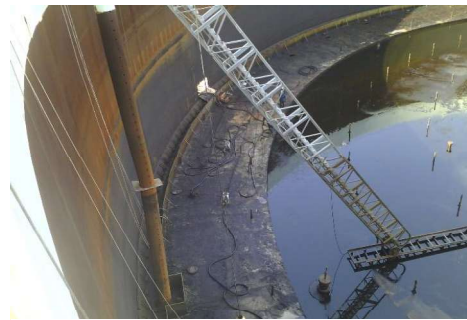
排空油品後の状況
