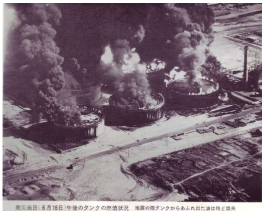
震災当日(6月16日)午後のタンクの燃焼状況。地震の際タンクからあふれ出た油は殆ど焼失
