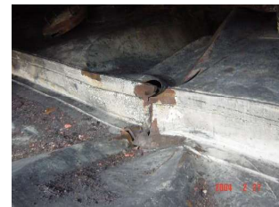
ポンツーンの座屈・破断
