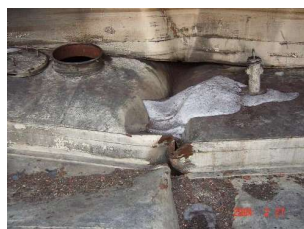
浮船扭曲變形、破損
