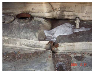
ポンツーンの座屈・破断
