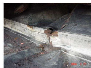
浮船扭曲變形、破損
