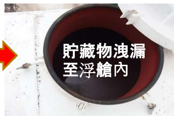
浮艙的底板破洞
