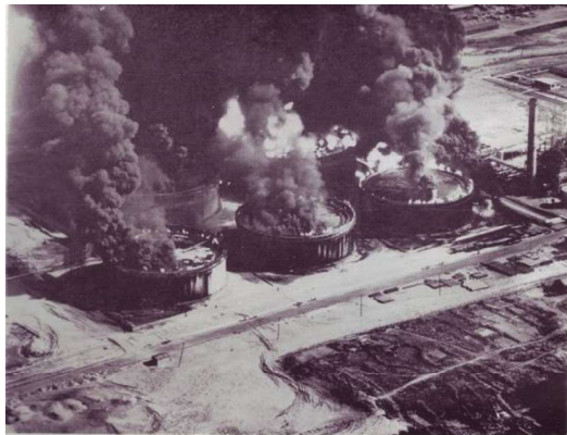
震災当日(6月16日)午後のタンクの燃焼状況。地震の際タンクからあふれ出た油は殆ど焼失
