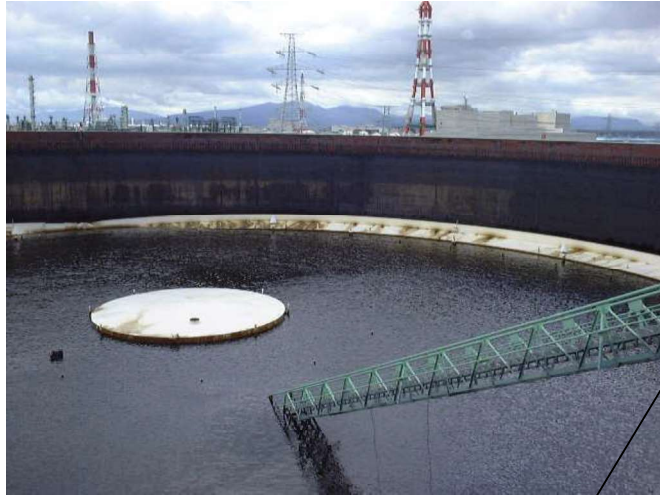
地震で沈没した浮き屋根109,900kL
