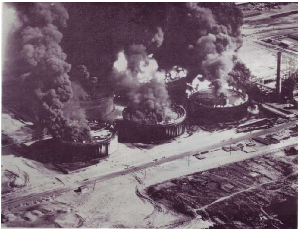
地震當天6月16日下午儲槽起火燃燒，因地震外溢的油幾乎全部燒盡。
