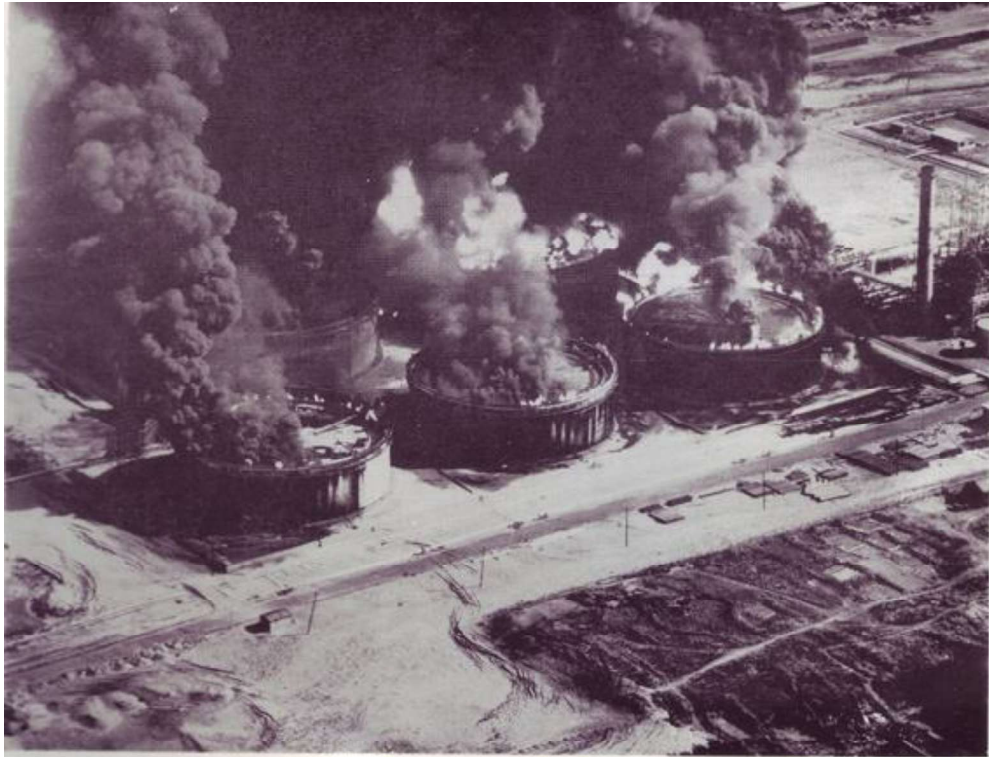
発災当日（6月16日）午後のタンクの燃焼状況 地震の際タンクからあふれ出た油は殆ど焼失
