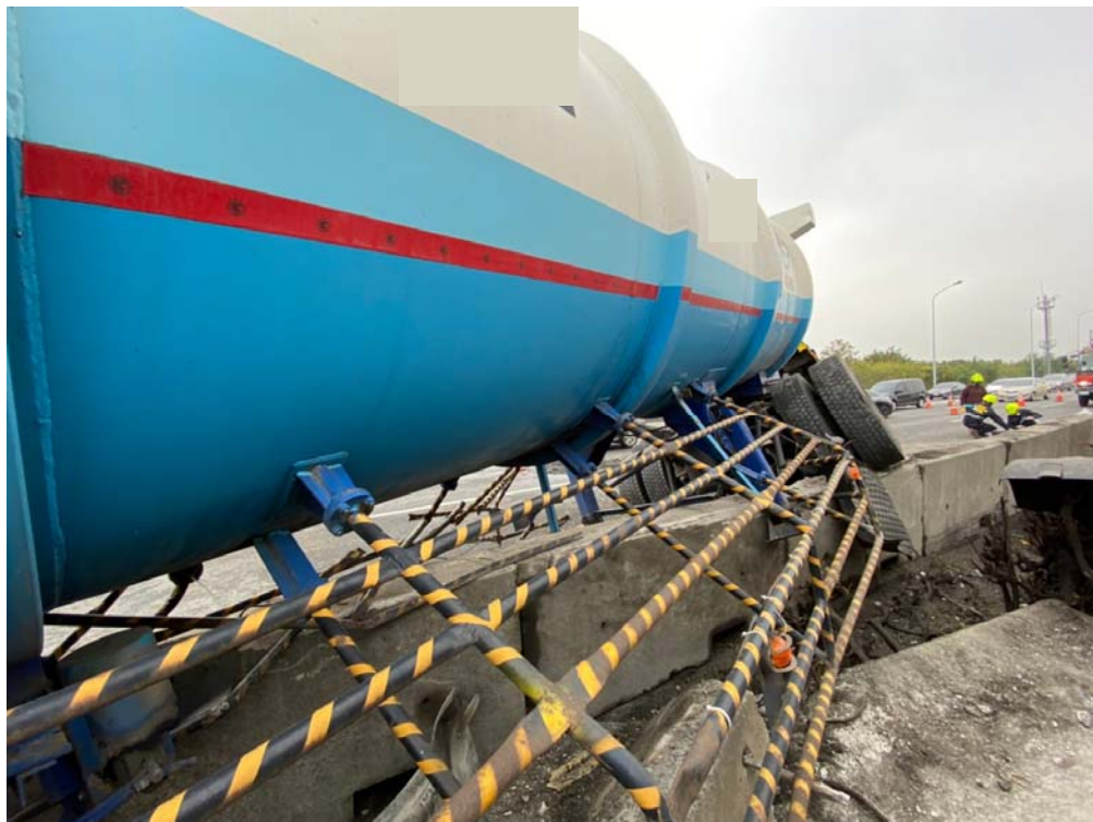
槽體左後車輪全破，另懷疑左腳架斷裂
