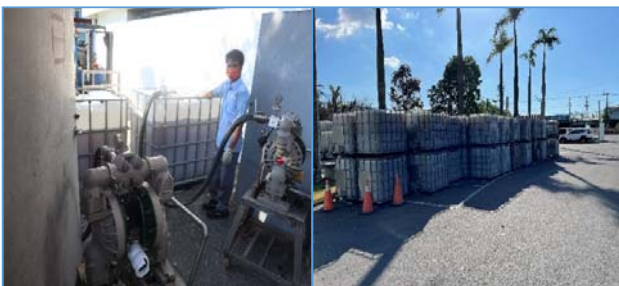
消防廢水抽除作業
